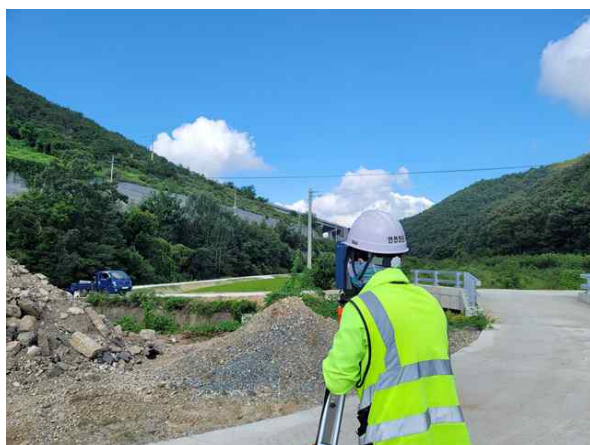
광파기를 이용한 측량 작업
