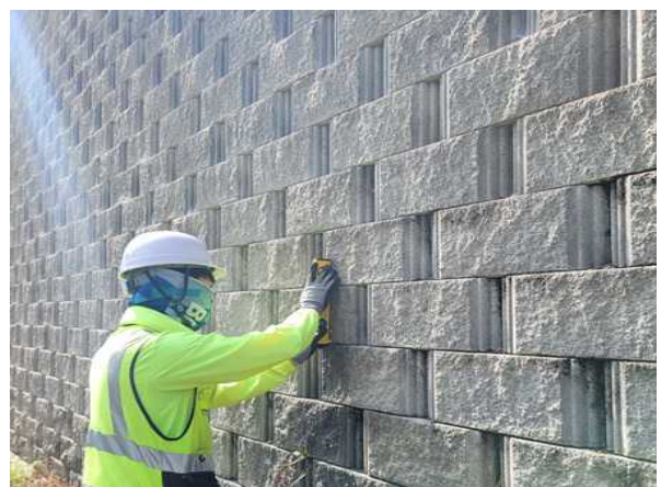
경사계를 이용한 경사도 측정
